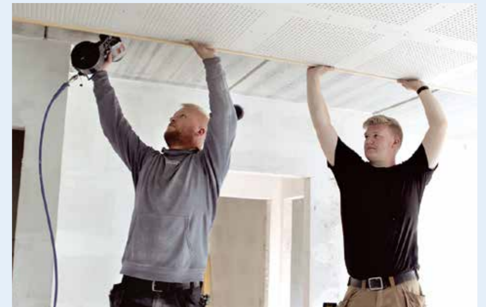
Tømrerne Christoffer Sondrup og Emil Ramsdahl, begge fra A/S Sondrup, Aars, installerer loftsplader med lyd-dæmpning i en af lejlighederne.
